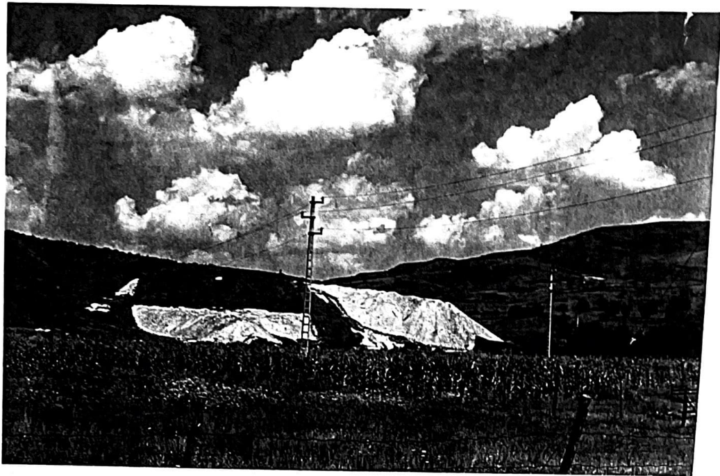
Fig. 1 – Halde de steril provenind de la exploatarea sărurilor de potasiu de la Găleanu
